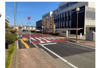
▲ゾーン30プラス(スムーズ横断歩道)
