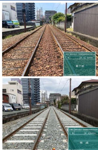
軌条更換竣工前後
