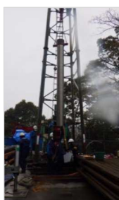
◀取水施設の新設(ケーシング挿入の様子)
