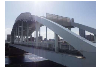
▲橋梁メンテナンス
