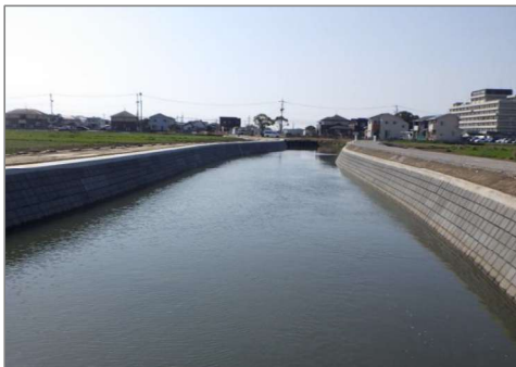
河川改修【河道拡幅・護岸整備】
