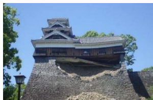
【被災直後の写真】 飯田丸五階櫓復旧工事
