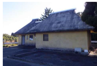
田原坂公園トイレ
