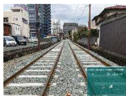
軌条交換竣工後
