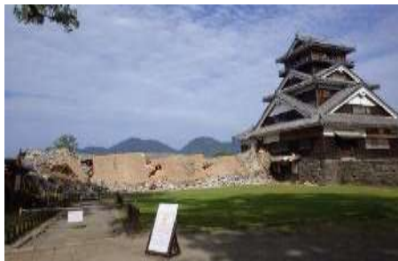
宇土櫓続櫓の地震当時の被災状況
