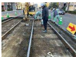
軌道整正の様子
