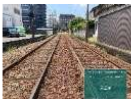
軌条交換着工前
