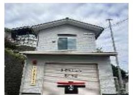
令和7年竣工 消防団機械倉庫 ▶
