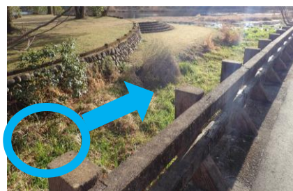
図 3-19（上江津湖・スイゼンジノリ発生地付近）以前は青枠内に湧水が発生し、矢印方向に水流があった
