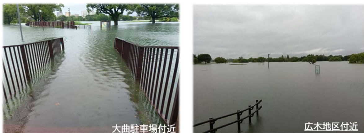
図 3-36 大雨時の水前寺江津湖公園の被災状況
