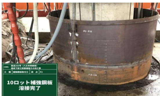
▲写真 橋梁の耐震化（八王寺跨線橋） （出典：熊本市資料）
