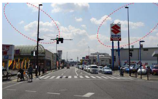
▲写真 道路の無電柱化（国道266号） （出典：熊本市資料）
