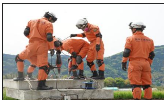
【コンクリート壁破壊（進入路確保）】
