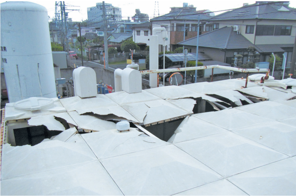
水が大きく揺れ動いたことで天井が割れた貯水槽
