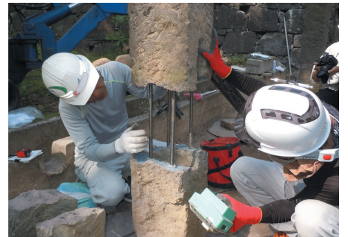
倒れた長堀の石柱の中にステンレスのボルトを入れて、つなぎあわせる
