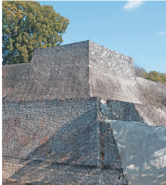
復旧が完了した飯田丸五階櫓の石垣。耐震補強のため、中には補強材が敷かれている
