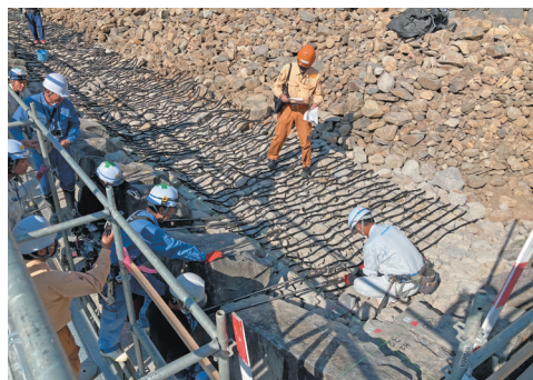
飯田丸五階櫓の石垣内部に設置される補強材
