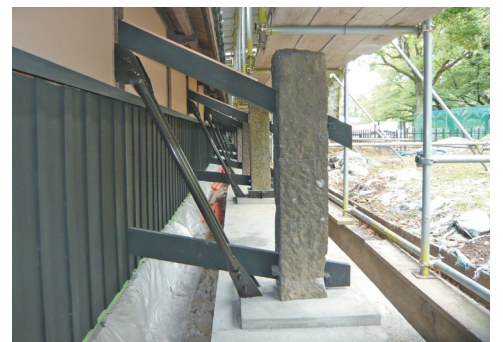
金物とコンクリートで補強し、復旧した長堀
