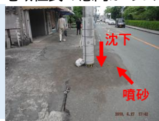
液状化の被害
