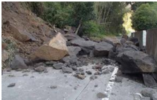
▲ 一般県道玉名植木線 法面の崩壊
