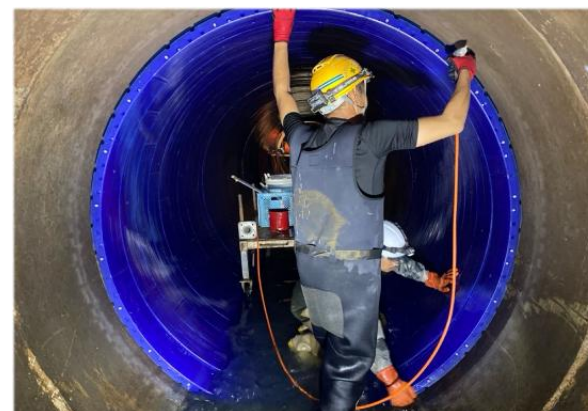
▲ 下水道管耐震化工事の様子
