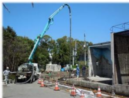
猛兽舎の復旧工事の様子
