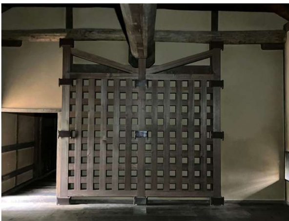
監物櫓 格子壁耐震補強
