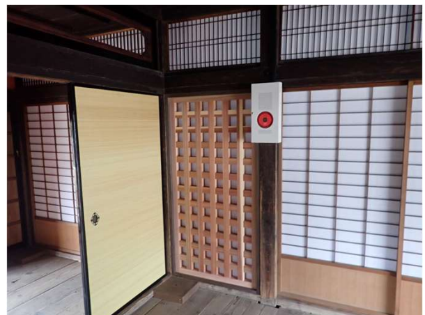
小島行在所 格子壁耐震補強
