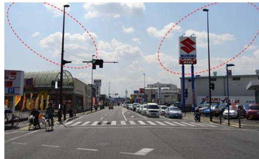
▲写真 道路の無電柱化（国道266号） （出典：熊本市資料）
