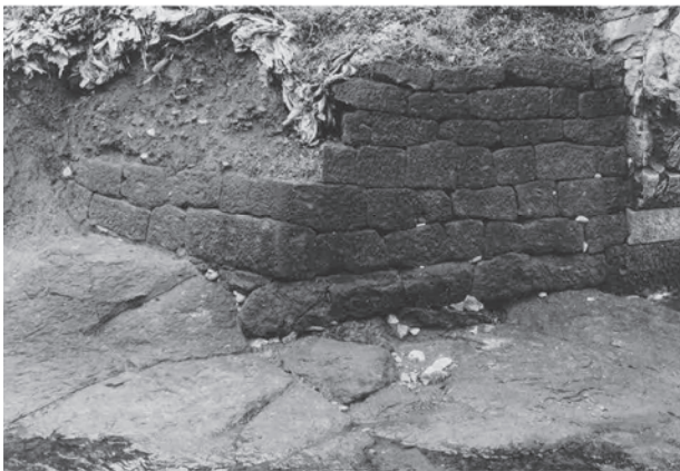
上流側左岸の護岸
