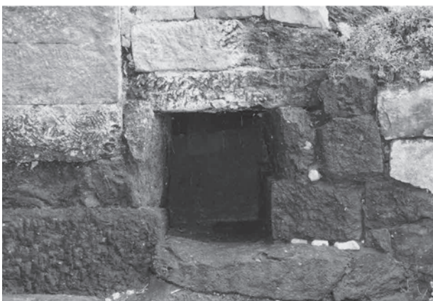
下流側左岸下部端の排水溝開口部
