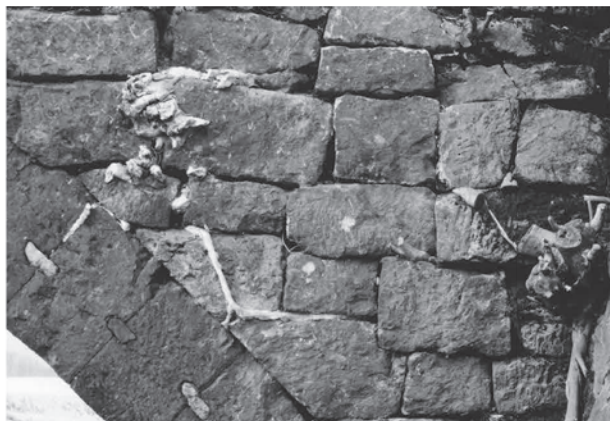
上流側右岸壁石の旧材
