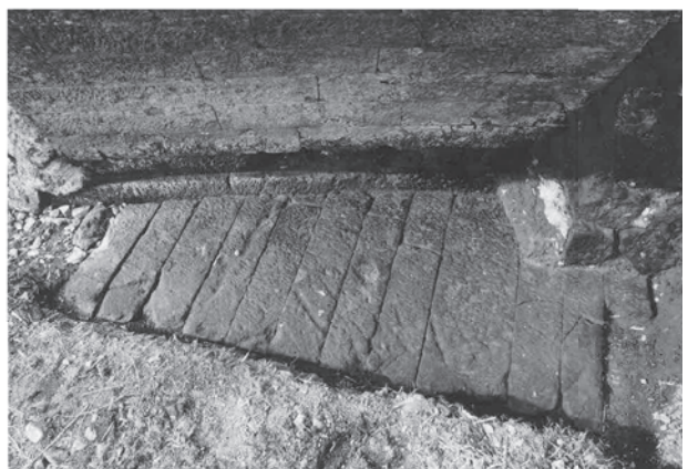
右岸基礎の敷石
