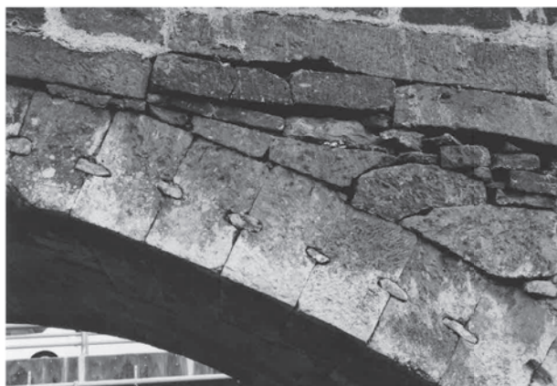
下流側左岸上部の旧材
