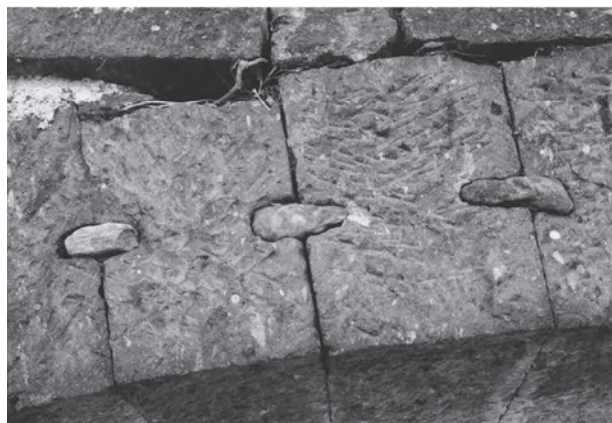
上流側左岸輪石の太柄
