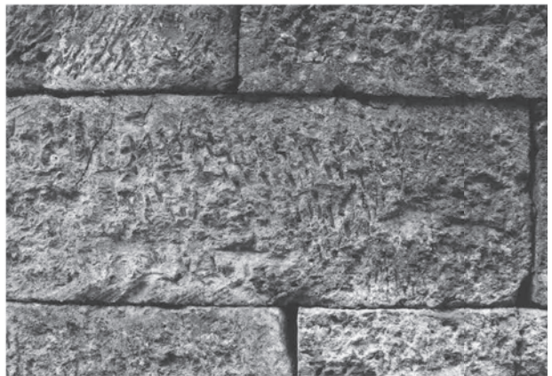
右岸輪石の工具痕
