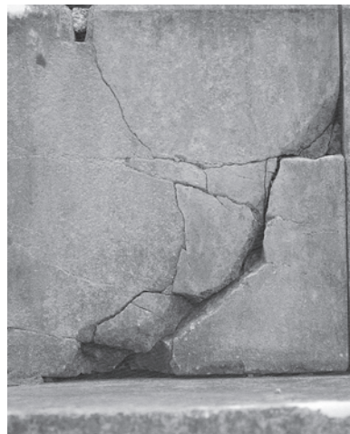
基壇 1 段目の台石右側面の毀傷
