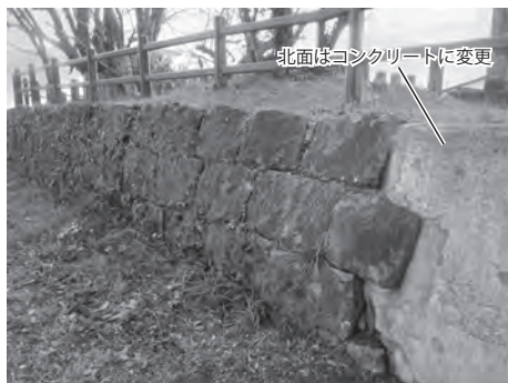
① 間知石積み擁壁（東面）
