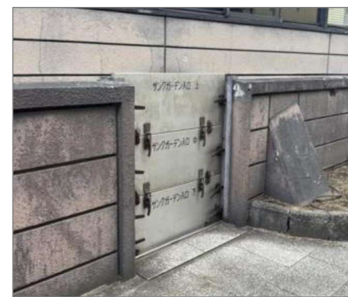
建具タイプ (地下進入口等に施工)
