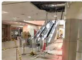
熊本地震後の市民病院
