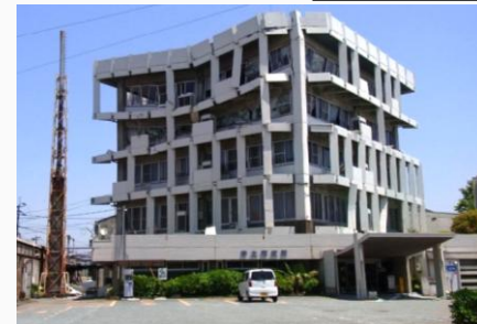
熊本地震後の宇土市役所
