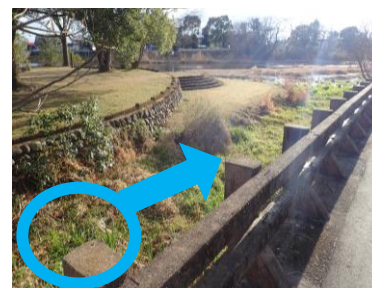
図 3-25（上江津湖・スイゼンジノリ発生地付近）以前は青枠内に湧水が発生し、矢印方向に水流があった
