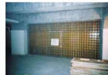
耐震補強の例(耐震壁の追加)
