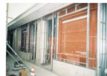
制振補強の例(粘性壁の追加)
