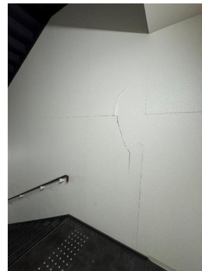
3階西側階段室
