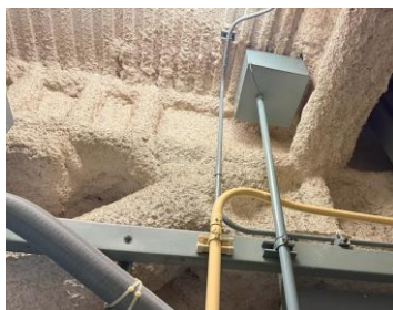
9階シャフト内
