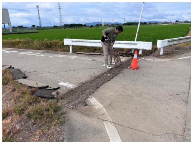
農道のクラックの仮修繕（東区秋津）
