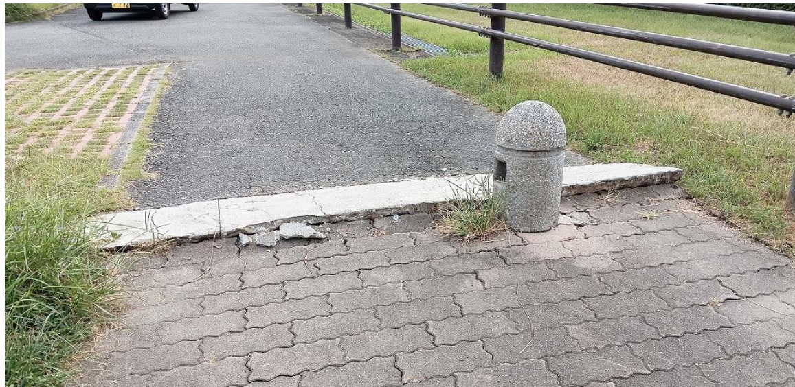
舗装の亀裂
