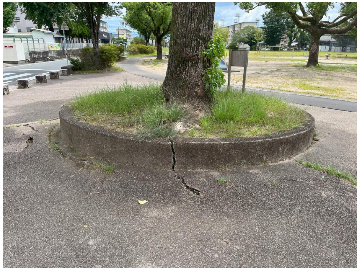
植樹枿ひび割れ
