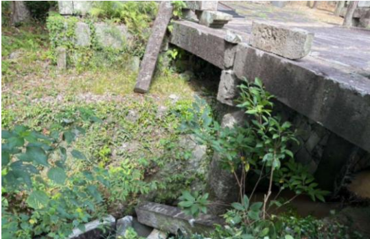
井芹都市下水路
