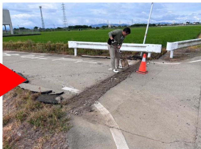
農道舗装板の仮修繕（東区秋津）
