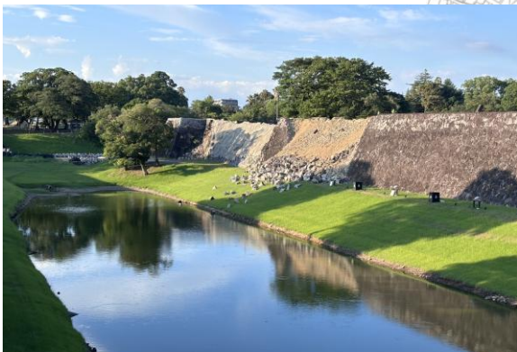
西出丸西側石垣 崩落
