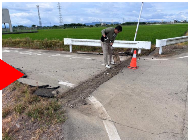
農道舗装板の仮修繕（東区秋津）
