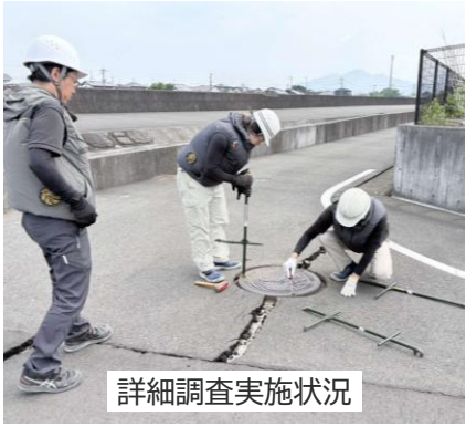
詳細調査実施状況
