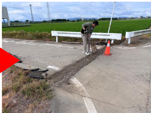
農道舗装板の仮修繕（東区秋津）
