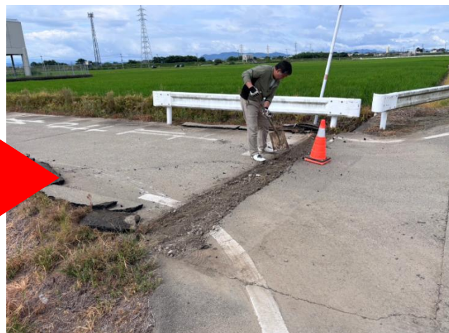
農道舗装板の仮修繕（東区秋津）
