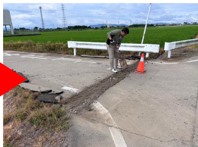
農道舗装板の仮修繕（東区秋津）
