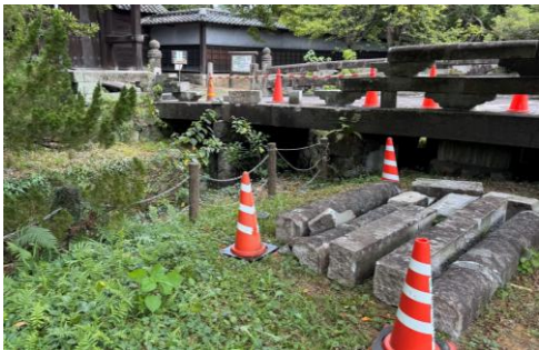
井芹都市下水路
