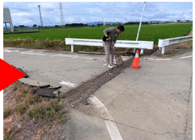
農道舗装板の仮修繕（東区秋津）
