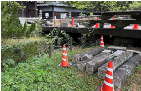
井芹都市下水路
