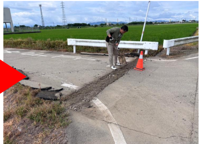
農道舗装板の仮修繕（東区秋津）
