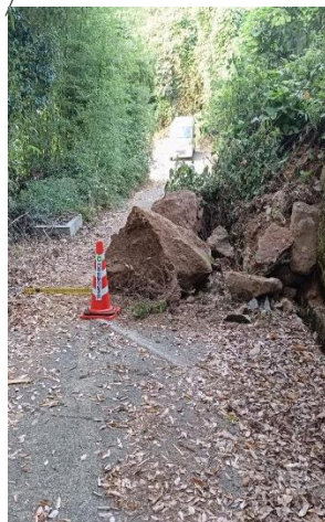
農道への落石（西区河内町）※8/4 撤去済
