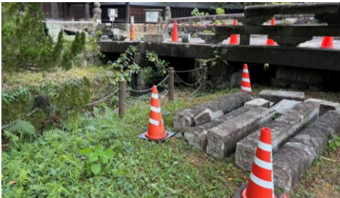
井芹都市下水路
