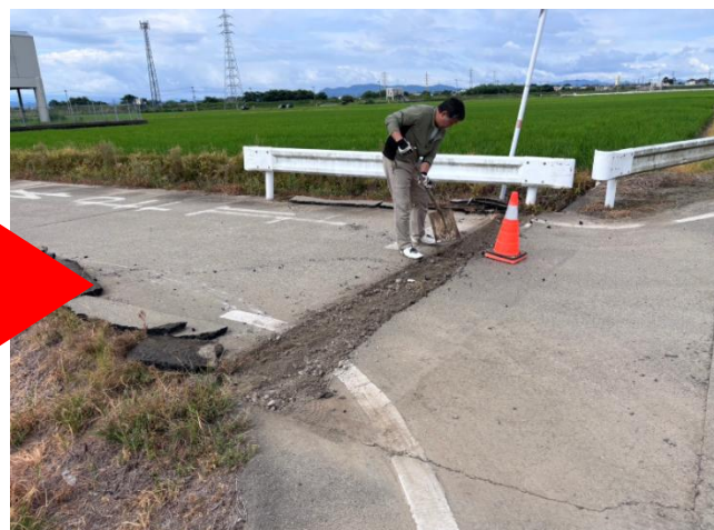
農道舗装板の仮修繕（東区秋津）
