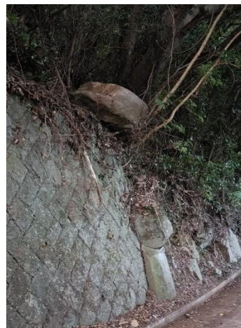
農道への落石（西区河内町）※8/4 撤去済
