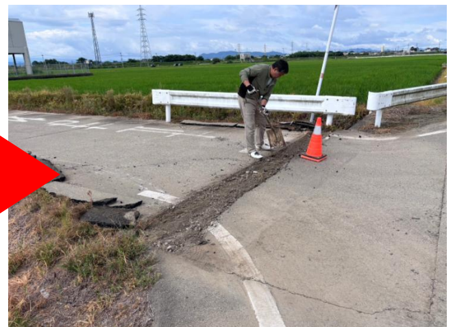
農道舗装板の仮修繕（東区秋津）
