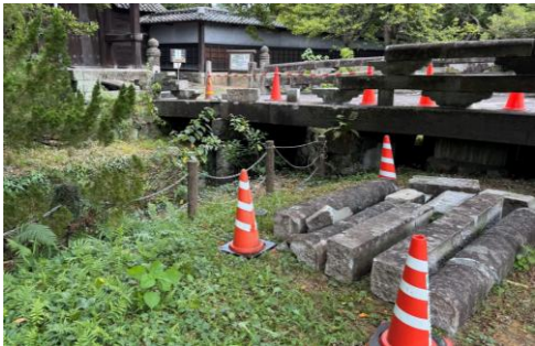
井芹都市下水路
