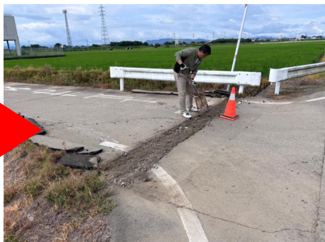
農道舗装板の仮修繕（東区秋津）
