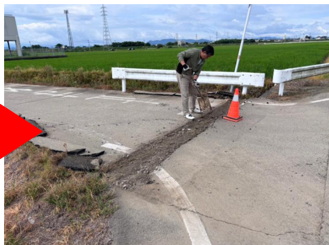
農道舗装板の仮修繕（東区秋津）
