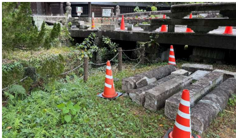
井芹都市下水路
