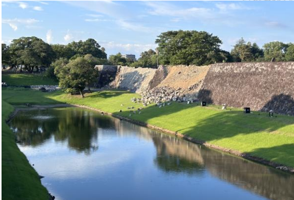
西出丸西側石垣 崩落
