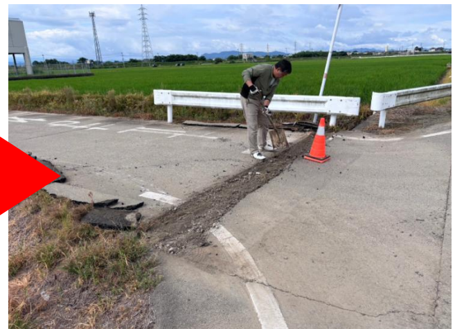
農道舗装板の仮修繕（東区秋津）
