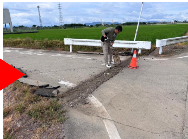
農道舗装板の仮修繕（東区秋津）
