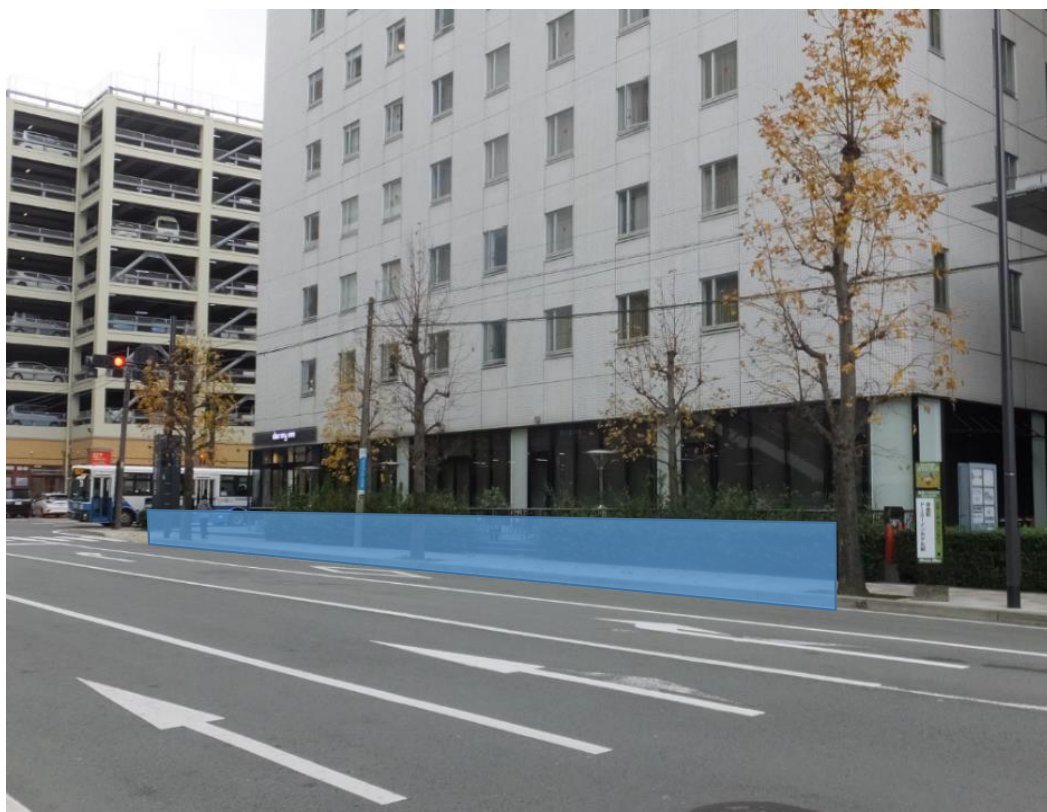
No.4 「市道 辛島町第1号線」熊本市中央区辛島町3番1号先
