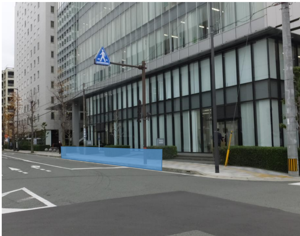
No.5 「市道 辛島町第1号線」熊本市中央区辛島町3番14号先
