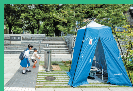
手押しポンプ(左)とマンホールトイレ(右)
