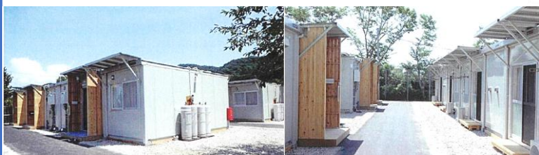
「参考:平成28年熊本地震の際に建設した仮設住宅」
