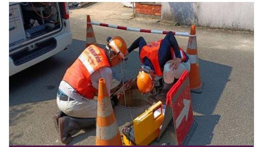
下水道復旧支援
