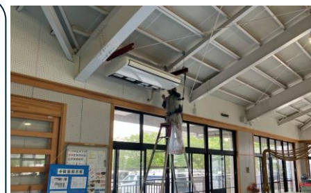
避難所へのエアコン設置
