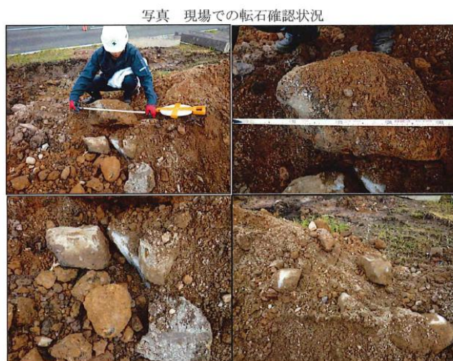
図 4-16 現場での転石確認状況
