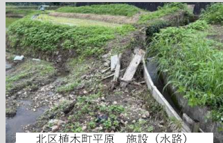
北区植木町平原 施設(水路) 水路柵破壊 L=3.0m
