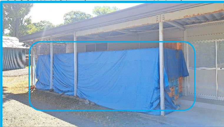
対象資料保管状況（三の丸整理室南棟下屋）
