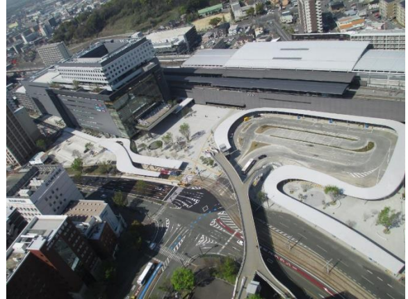
熊本駅白川口駅前広場
