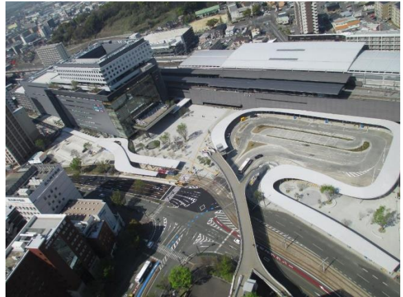
熊本駅白川口駅前広場
