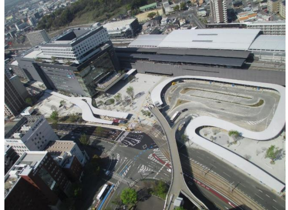
熊本駅白川口駅前広場
