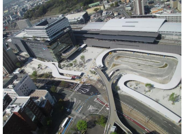
熊本駅白川口駅前広場
