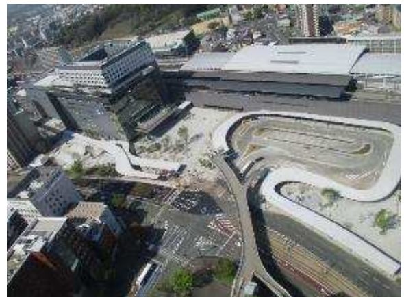
熊本駅白川口駅前広場
