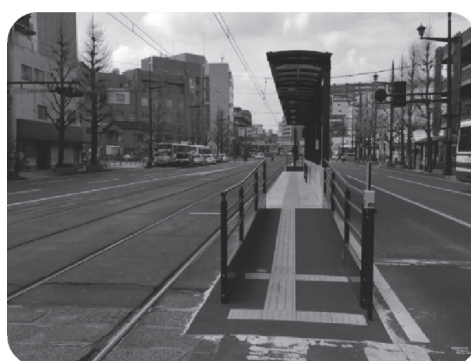
バリアフリー化された電停 (中央区大江)
