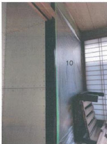
① 面材施工後
