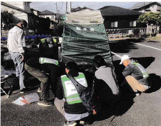
マンホールトイレの設置訓練もありました
